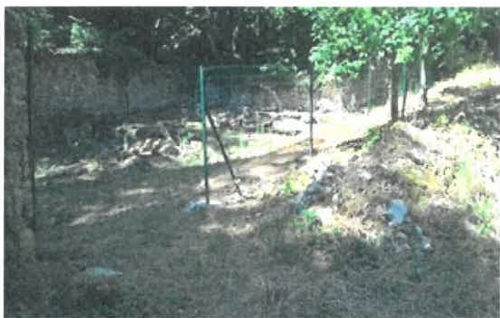
Pose d'une clôture au lavoir au Parc
