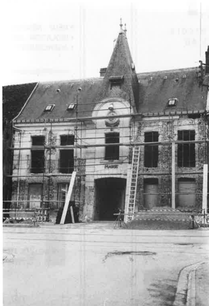
Le lifting de la façade... COMMENCE
